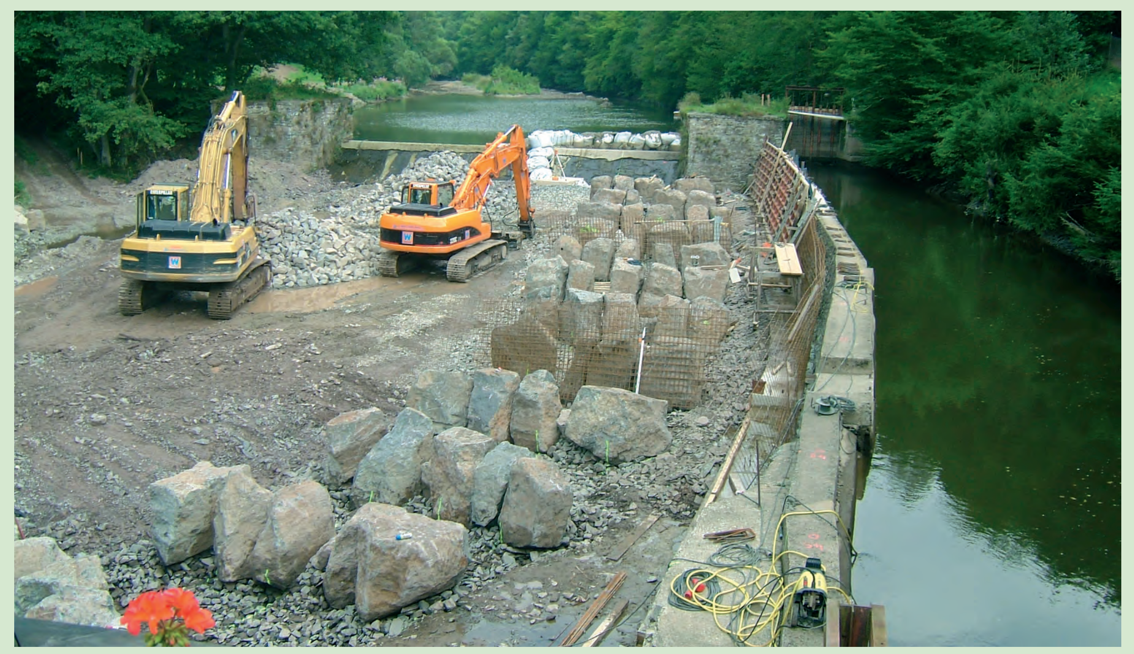
Baumaßnahmen an der Rellesmühle 2005
