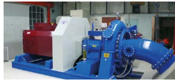
Abb. 15: Moderne Mühlentechnik I / Francis-Turbine
